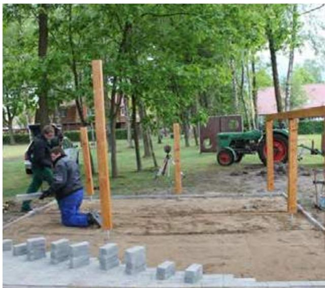
Am Samstagmorgen traf sich das Bauteam bereits um 7 Uhr, um den Untergrund fertig zu stellen und nach dem Frühstück mit dem Pflastern zu beginnen. Nachdem fertig gepflastert war, wurden die Dachkonstruktion und die Wände gebaut. Zur selben Zeit liefen im Hintergrund der Einkauf der Materialien, sowie die Planung der Umsetzung des Sonntags ab. Geplant wurden „Spiele ohne Grenzen“ und ein Kaffee- und Kuchenbuffet. Abends sollten noch Pommes und Bratwurst verkauft werden.
