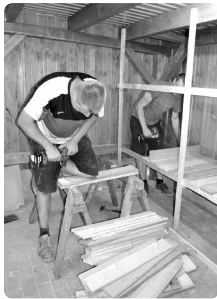
Aufbau eines neuen Regals
