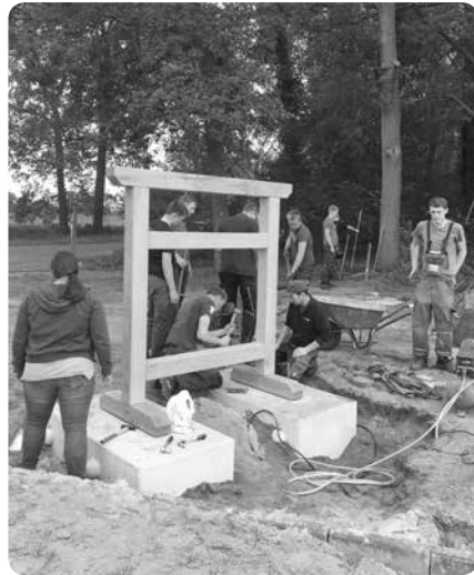
Bau der überdachten Fachwerkwände bei unserer letzten 72-Stunden-Aktion.
